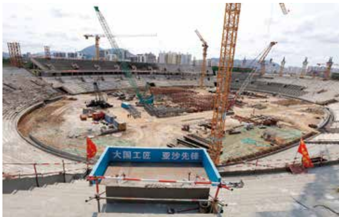
三亚国际体育产业园施工现场 图片拍摄：王康宏
