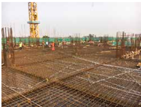
A区顶板钢筋绑扎
