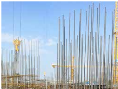
D区地下墙体钢筋绑扎
