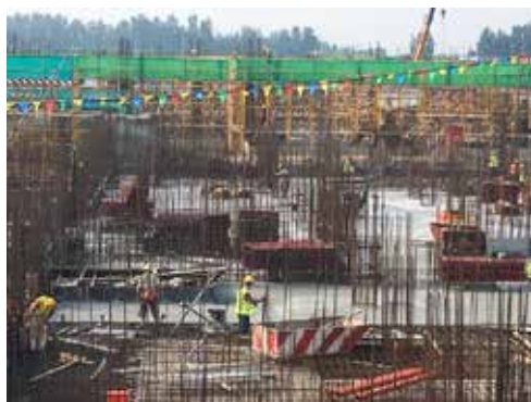
B区基础底板砼施工
