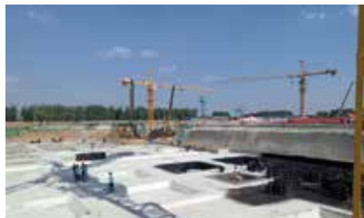
D区桩基施工
