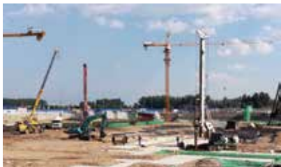
A区基础垫层及灌注桩施工
