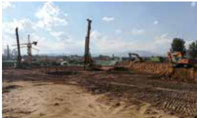
B区土方施工
